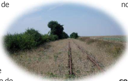
Passage de la voie ferrée à Coltainville (Chartres métropole)
