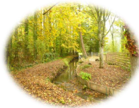
Berges de la Roguenette à Gasville-Oisème : la pose de planches en bois empêche la colonisation par la végétation (Even Conseil)
