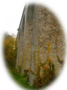
Le pont de la voie ferrée à Oisème (Even Conseil)
