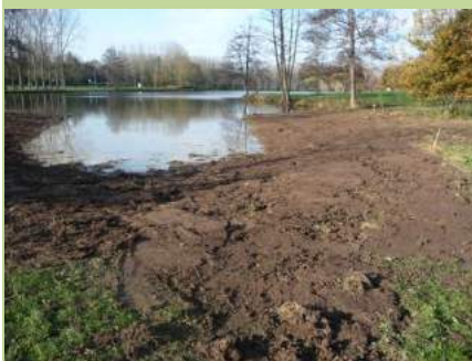
Berges de l'étang de Barjouville reprofilées en pente douce pour permettre aux ceintures végétales de se développer (2011, Cen Centre) (Cen Centre/M. Baudoin)
