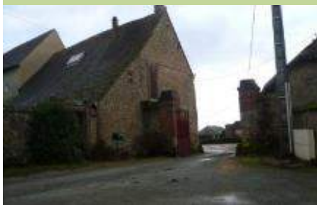
Usage de la brique de l'argile à silex à Saint-Germain-la-Gâtine ( Even Conseil )
