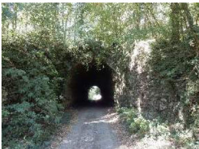
Ouvrage du canal sur la commune de Maintenon (B. Lambert)
