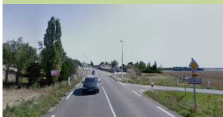
Passage de la RD939 à Dangers : franchissement dangereux (Google)
