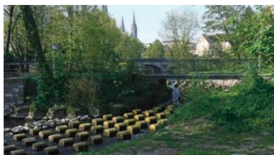
Vannage réaménagé Place drouaise à Chartres
