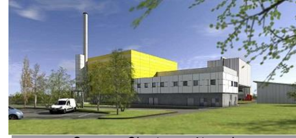
Future usine de cogénération biomasse à Gellainville
