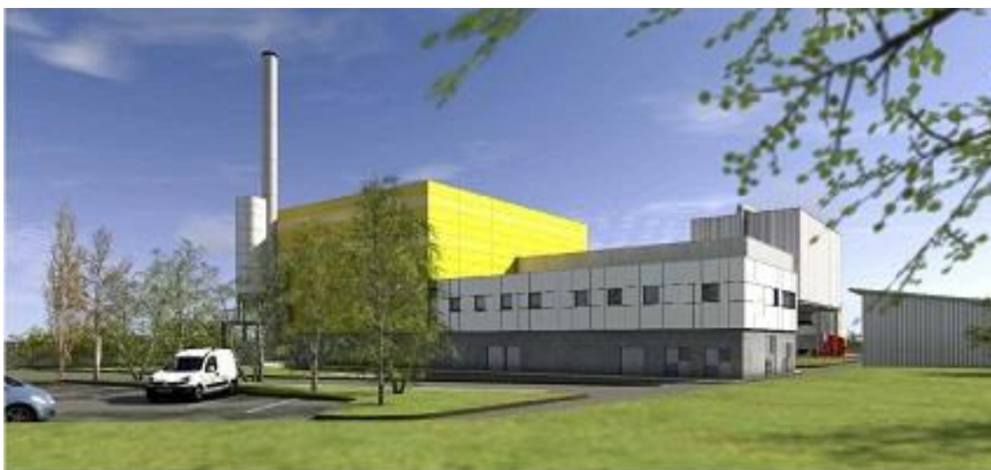
Future centrale de cogénération biomasse à Gellainville
