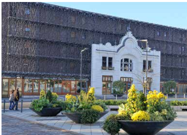
C'est Rudy Ricciotti qui a entouré la façade du cinéma Les Enfants du Paradis d'une résille préfabriquée en béton de fibres à ultra-hautes performances. Une première mondiale, à Chartres !
