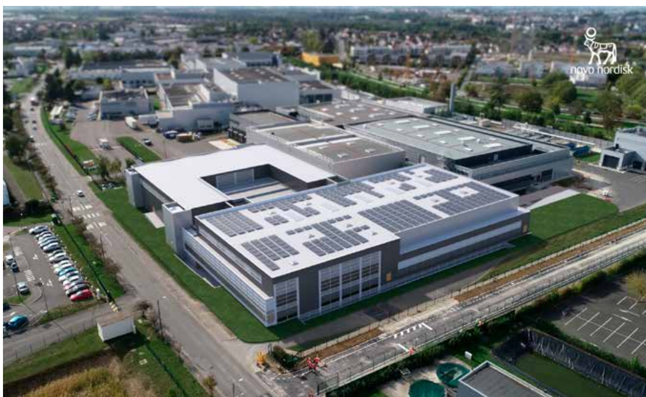
Futurs bâtiments de produits finis et bâtiment logistique.
