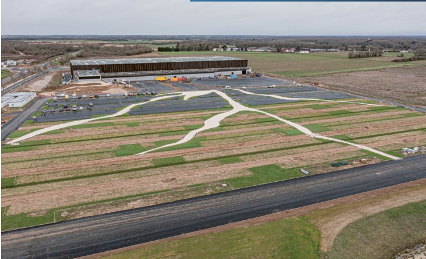
Enrobés et cheminements piétonniers du parking visiteurs sont terminés. Les travaux de voirie autour du site sont sur le point d'être finalisés, en attendant les aménagements paysagers.
