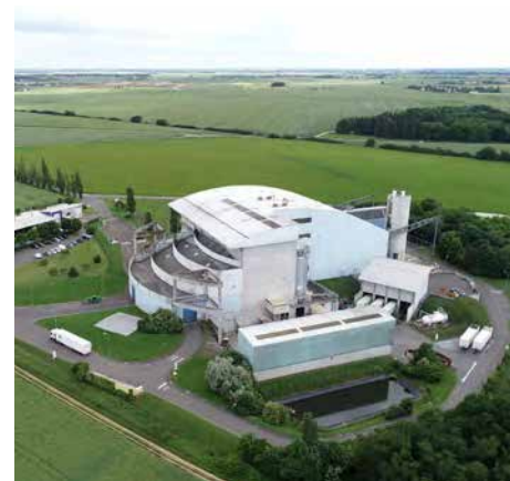
Unité de Valorisation Énergétique.
