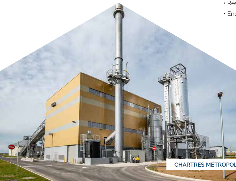
Centrale de cogénération biomasse (Gellainville).
