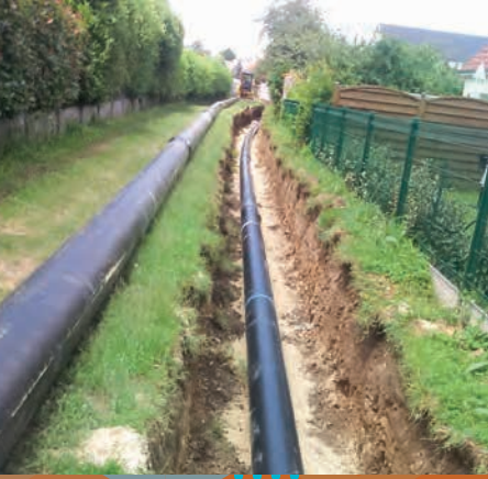
L'extension du réseau de chaleur.
