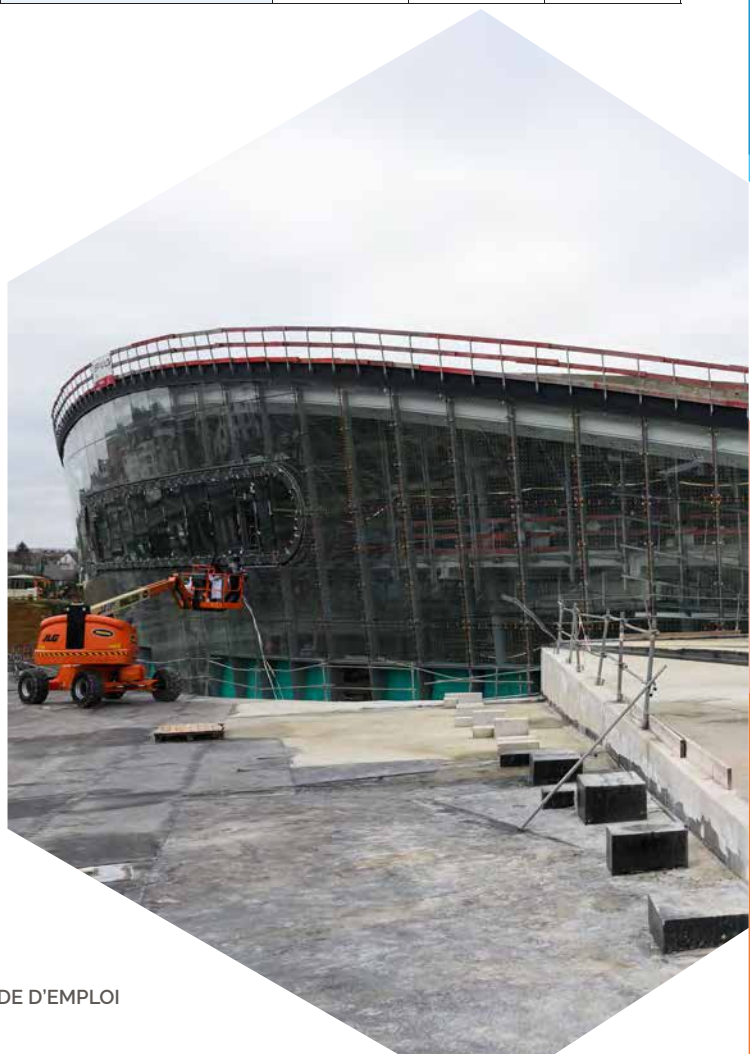
Le chantier du Colisée, février 2023 (livraison 2024).
