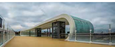
Le Pôle-Gare - Passerelle.
