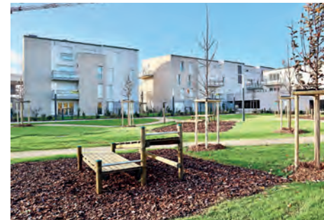
Quartier Les Clos à Chartres : 14 logements mis en location, au sein de l'ensemble immobilier Renouv'o.
